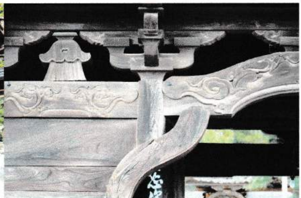
写真-5 琴柱花頭風通路は、反り返しのある角柱と冠木で構成される
