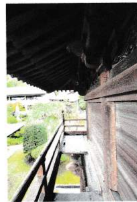
写真-8 上層の側柱と架構
