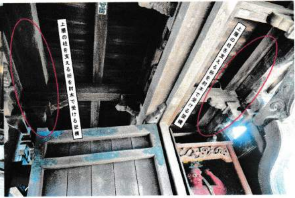
写真-7 上層の柱が建つ桁を出三斗の巻斗と肘木で受けている
