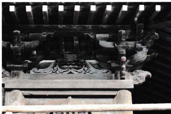
写真-1 1 入母屋屋根の軒組は二軒に 二手先と蟄股での構成
