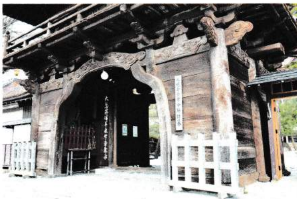
写真-4 木製礎盤上に円柱を建て、地覆・足固貫・頭貫で下層を固めている
