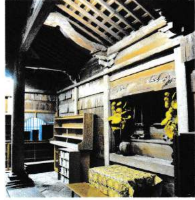
写真-11 海老虹梁を受ける出三斗の来迎柱
