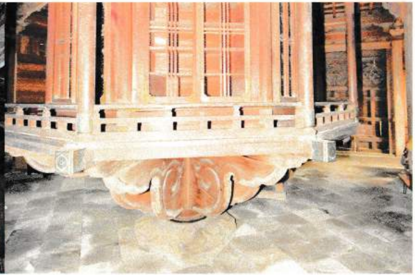
写真-3 転輪蔵下部は繰形付軸組を支持
