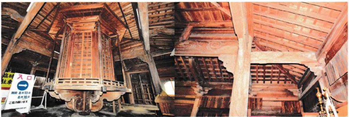
写真-4 転輪蔵を護る四周の円柱と架構
