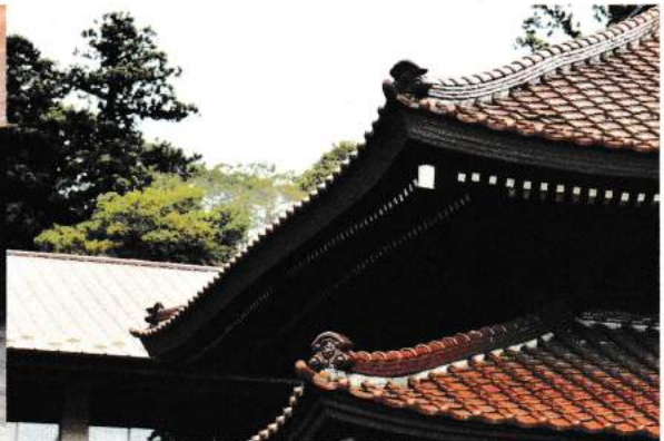
写真-13 桎葺を重い棧瓦葺きに替えたために屋根が波打っている
